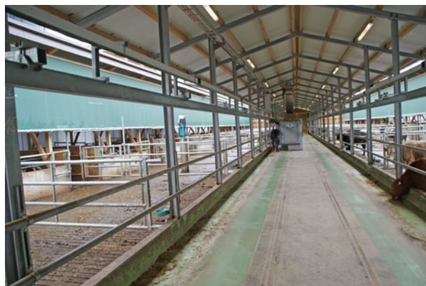
Vue du couloir d'affouragement entre les moments d'alimentation.
